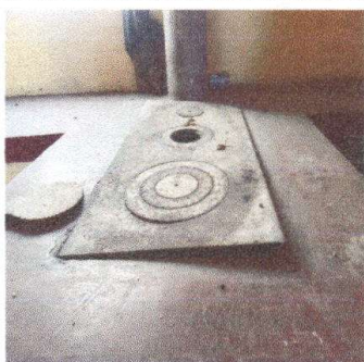
Foto 5: Sustrucción de plancha de metal de 3 hornillas
