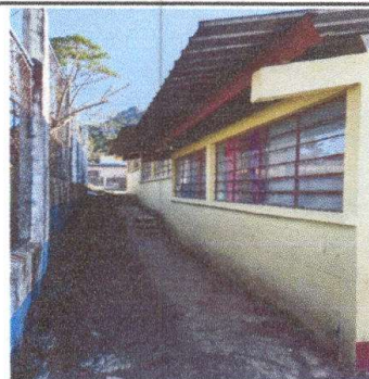
Foto 6: Reparación de planchas de concreto de patio
